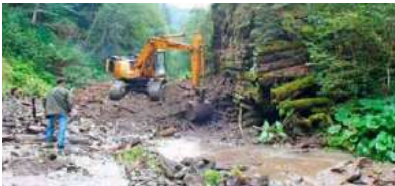
Демонтаж незаконної греблі
